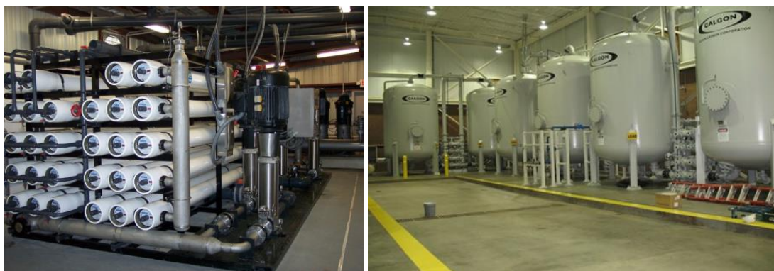
Zahl 3 - RO-Membranen und -Filter leiden unter Ölverschmutzungen und Verschmutzungsereignissen
