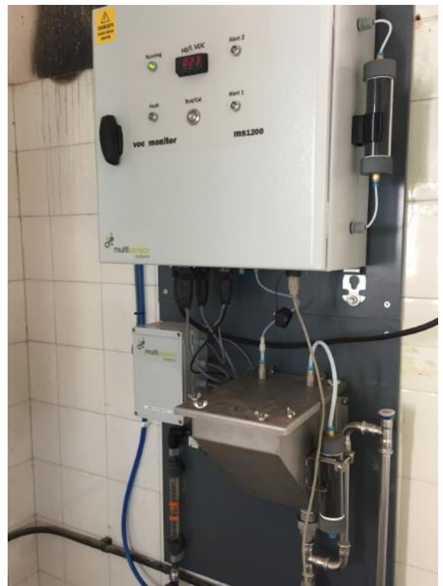
Zahl 17 - - Ein Bild der Einheit, die in einem Nebengebäude neben dem Bohrloch installiert ist.
